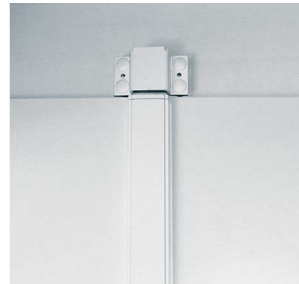
Illustration 7: Crémone avec point de fermeture en haut
