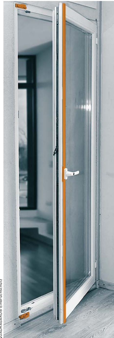
Illustration 10 : Crémone d'une porte vitrée de balcon
