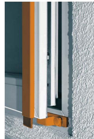
Illustration 12 : Crémone de fenêtre avec point de fermeture en bas
